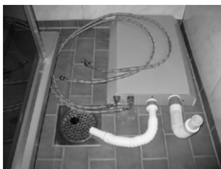
Duschvärmväxlare för duschkabin.
